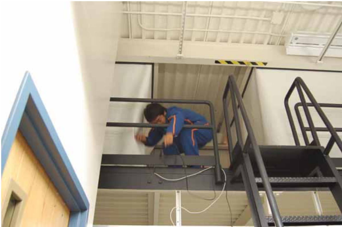
アラスカ観測所作業（9月）
